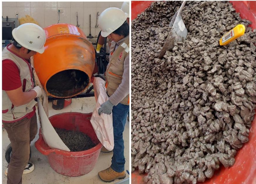
Vaciado a la batera de recepción del concreto Poroso.
